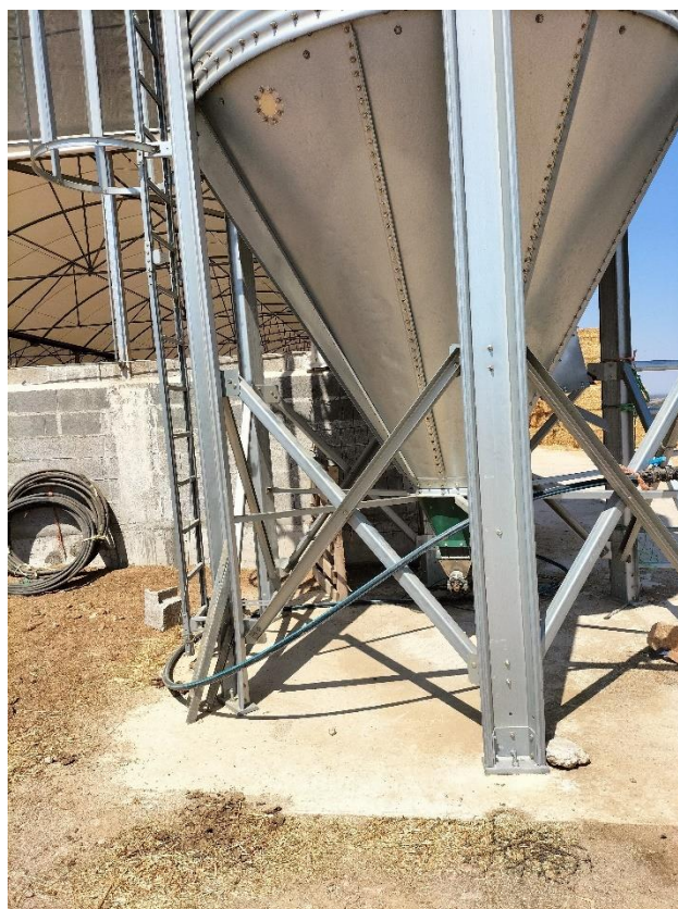
Fotografia 2: Pormenor das áreas pavimentadas – silo.
